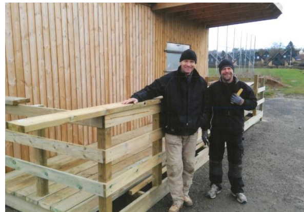
Under opførelsen af den første terrasse
