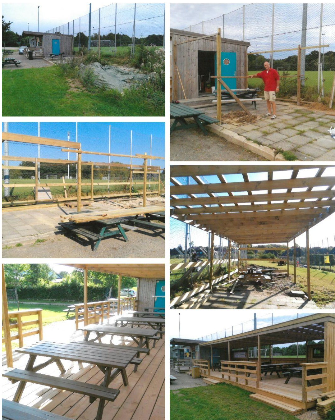
Under opførelsen af overdækning
