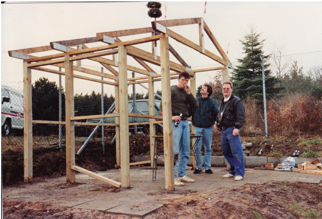
Rejsegilde for Corner
