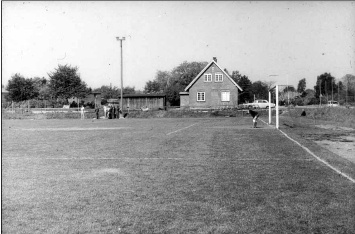
Fodboldbanen ved Krogebakke. I baggrunden ligger det oprindelige maskinhus til Aalgaard Teglværk, Krogebakke 9. I dag ligger kulturhuset Bølgen og tankstationen på stedet. SE 1965
