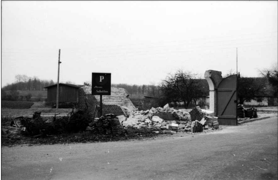
Det gamle sprøjtehus på Krogebakke med den håndbetjente brandsprøjte måtte lade livet ved Teglværksgårdens udstykning. Skåningevej er ved at blive etableret. HR 1959
