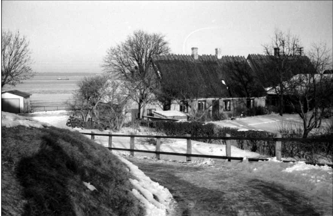
Nedkørslen fra kirken til Strandvejen, huset midt i billedet er Ndr. Strandvej 165. Der er is på Sundet. JU 1955
