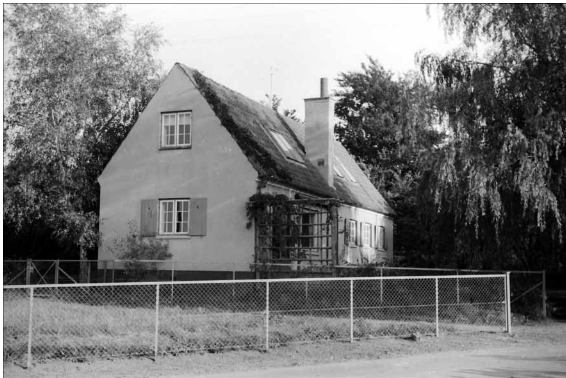
Villa Landlyst, Turbinevej 5. Her lå klædefabrikkens børnehave indtil børnehaven på Hammermøl- levej blev bygget. I dag er her privat beboelse. JU 1950
