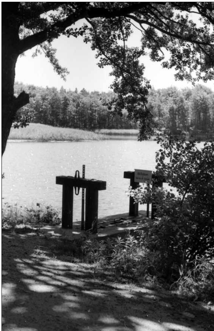
Stigbordet ved Kobberdammen, herfra ledes vandet til Skriverdammen. Vandsystemet er fra Christian IV's tid. JU 1952
