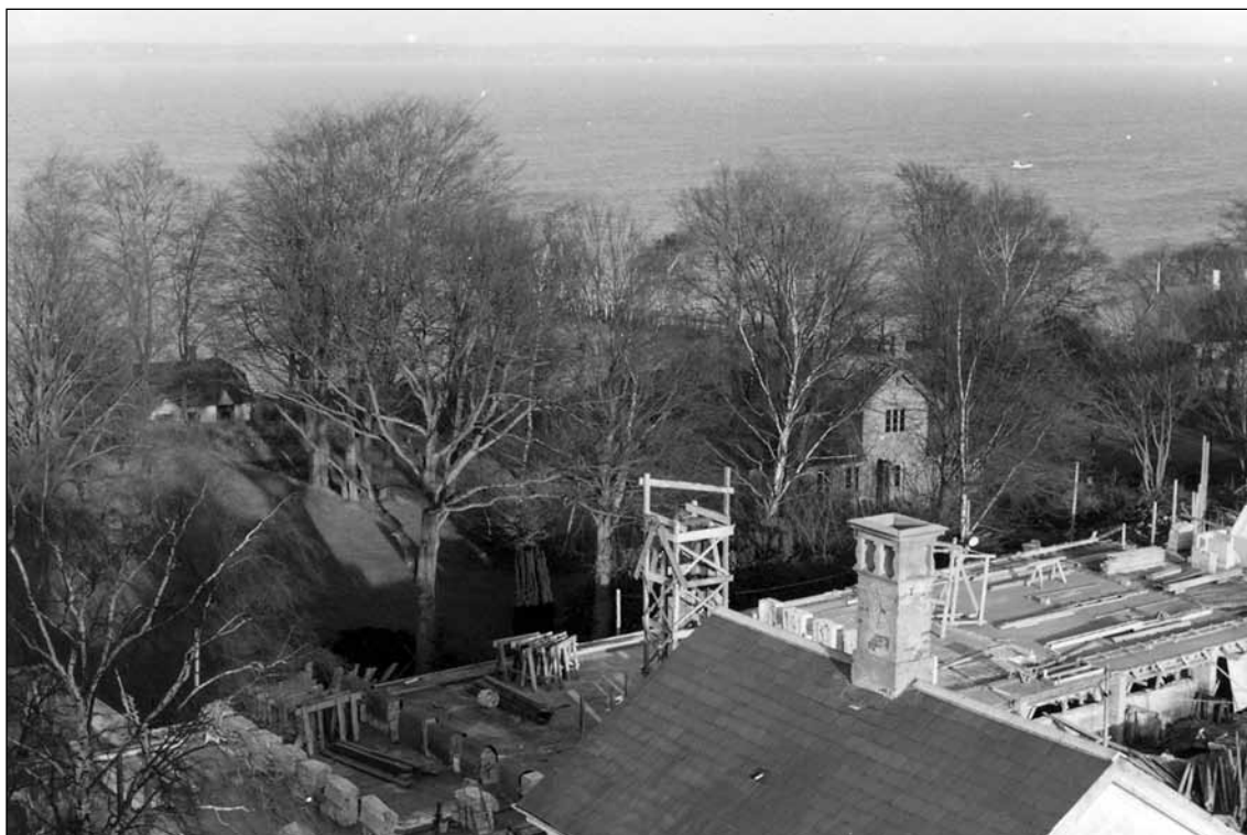
Den nye etageejendom Lille Odinshøj er under opførelse. Den gamle villa i haven ses mellem birketræerne. SE 1954
