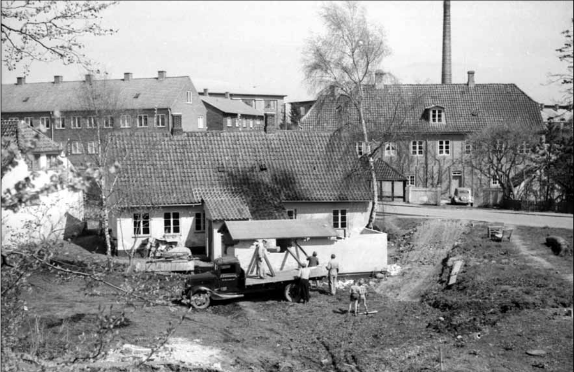
Byggeri ved Bøssemagergade 20. I dag ligger her et dobbelthus fra 1958. Overfor ses Probermesterboligen eller Lægeboligen, Caroline Mathildes Vej 2. Foran huset holder Dr. Teisens Citroën. Den høje skorsten er Hellebæk Klædefabriks. JU 1955
