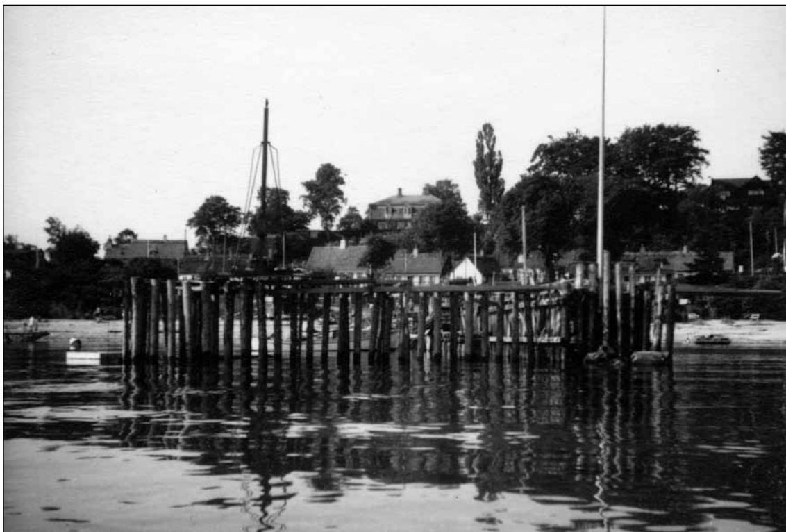
Det nye brohoved mod øst under opførelse. SE 1955
