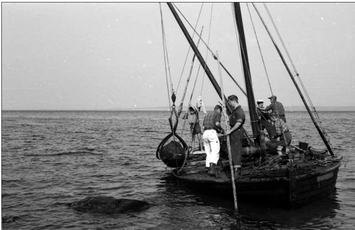
Brolauget anskaffede stenfiskerflåden Tor, som blev brugt til at fiske de sten, der blev lagt i det nye brohoved. Her fiskes sten fra den gamle Vestre Landing. HR 1955
