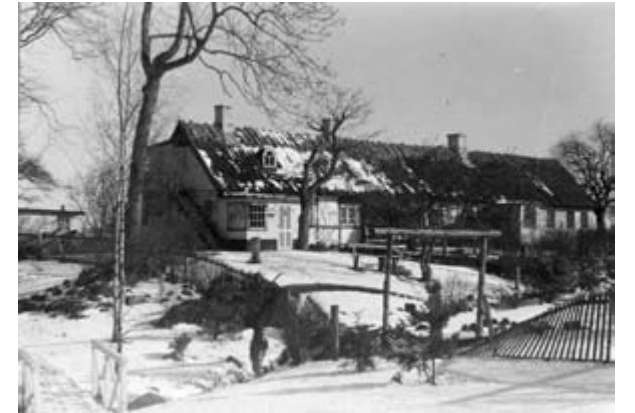
Det Lave Hus, Ndr. Strandvej 112 - 116. Foto: S.E. B1088.
