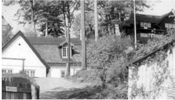
Fra nedgangen til Langebro ses Ønskekvisten øverst til højre. Foto: S.E. D-2287.
