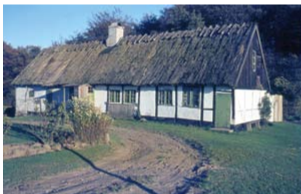
Engvangshuset. Foto: S.E. D-0504.
