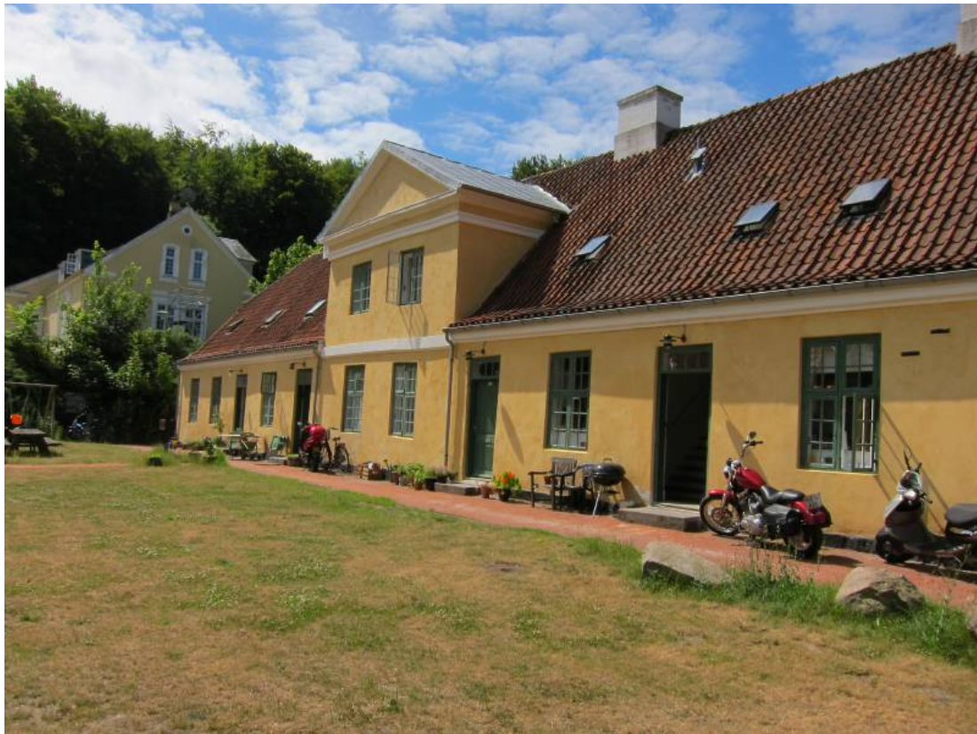
Raketskorpsets kaserne i dag, hvor bygningen er fredet. Den rummer nu private boliger.
